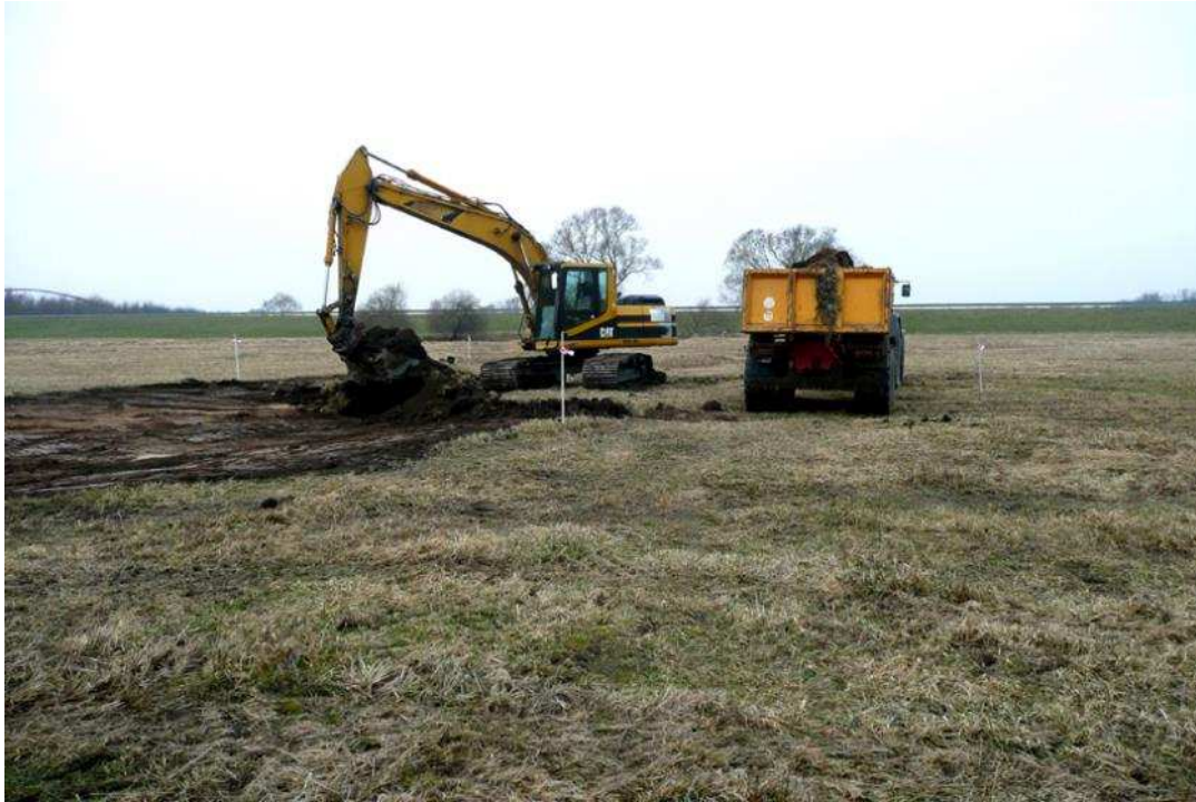
Bau des Kleingewässers
