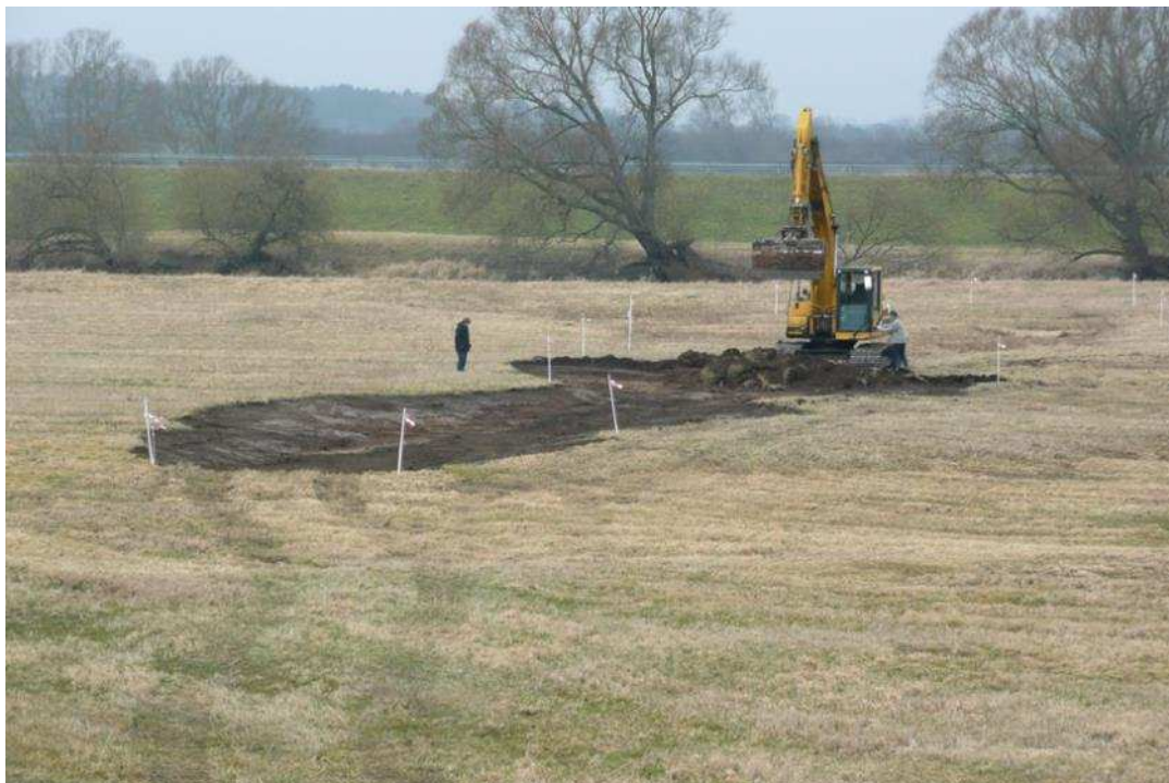
Bau des Kleingewässers unter fachkundiger Aufsicht.
